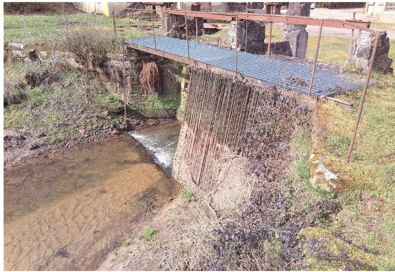
Figure n°40 : PK153 Amont prises d'eau 1 et 2 (vue rive droite) (22/03/23)
