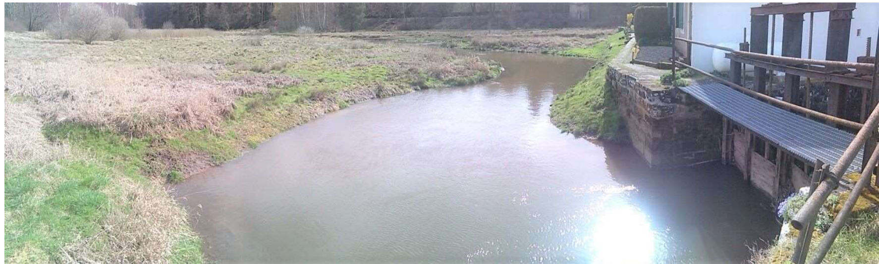
Figure n°26 : PK160 AMONT VANNES-BARRAGE (25/03/23)
