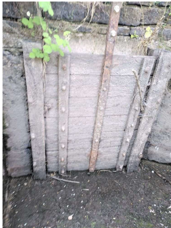
Figure n°48 : PK144 Prise d'eau 2 Amont vanne fermée (12/06/23)
