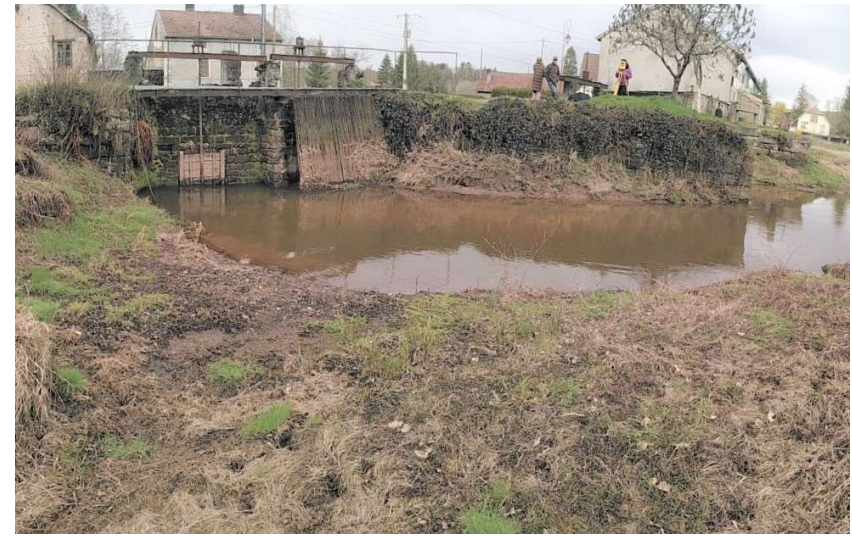
Figure n°41 : PK153 Amont prises d'eau 1 et 2 (vue rive gauche) (23/03/23)
