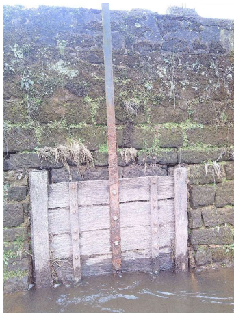
Figure n°42 : PK144 Prise d'eau 1 Amont vanne ouverte (25/03/23)
