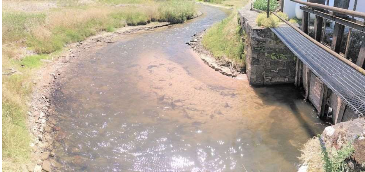
Figure n°27 : PK160 AMONT VANNES-BARRAGE (12/06/23)
