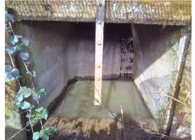
Figure n°53 : PK144 Prise d'eau 3 Aval grille sans vanne (22/03/23)
