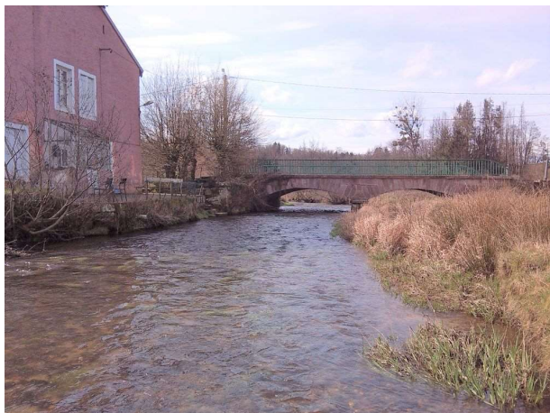
Figure n°9 : PK0 AVAL (au fond pont de la RD3)(22/03/23)
