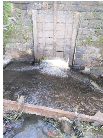
Figure n°43 : PK144 Prise d'eau 1 Amont vanne ouverte (12/06/23)
