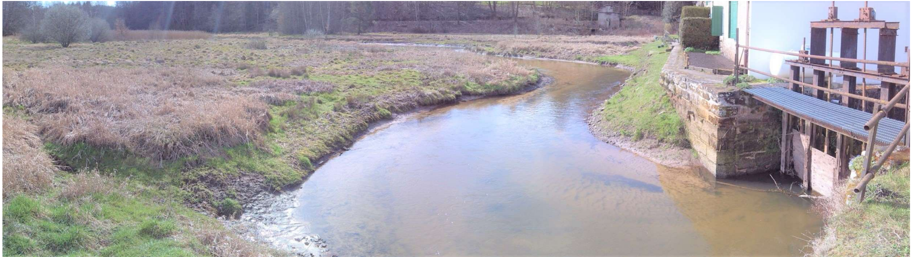
Figure n°25 : PK160 AMONT VANNES-BARRAGE (22/03/23)
