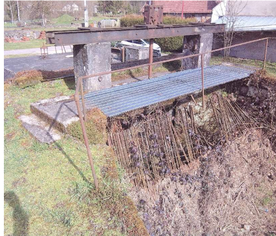
Figure n°52 : PK144 Prise d'eau 3 Amont (grille sans vanne) (22/03/23)
