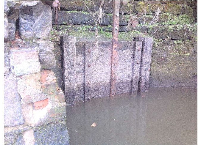
Figure n°47 : PK144 Prise d'eau 2 Amont vanne fermée (25/03/23)
